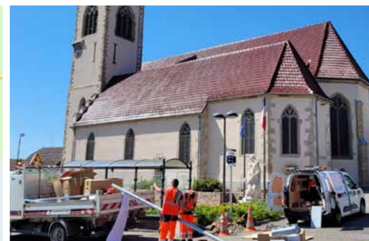
Installation du dispositif à l'arrêt « Église » en juin dernier
