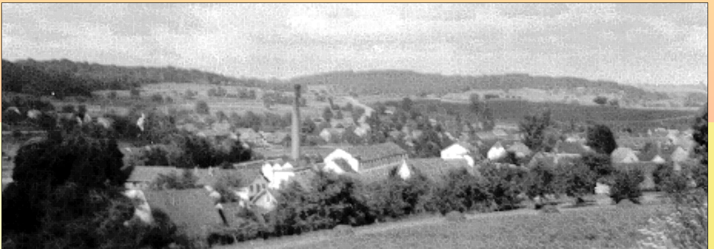
Vue prise depuis le Bux vers l'usine Lang ...
