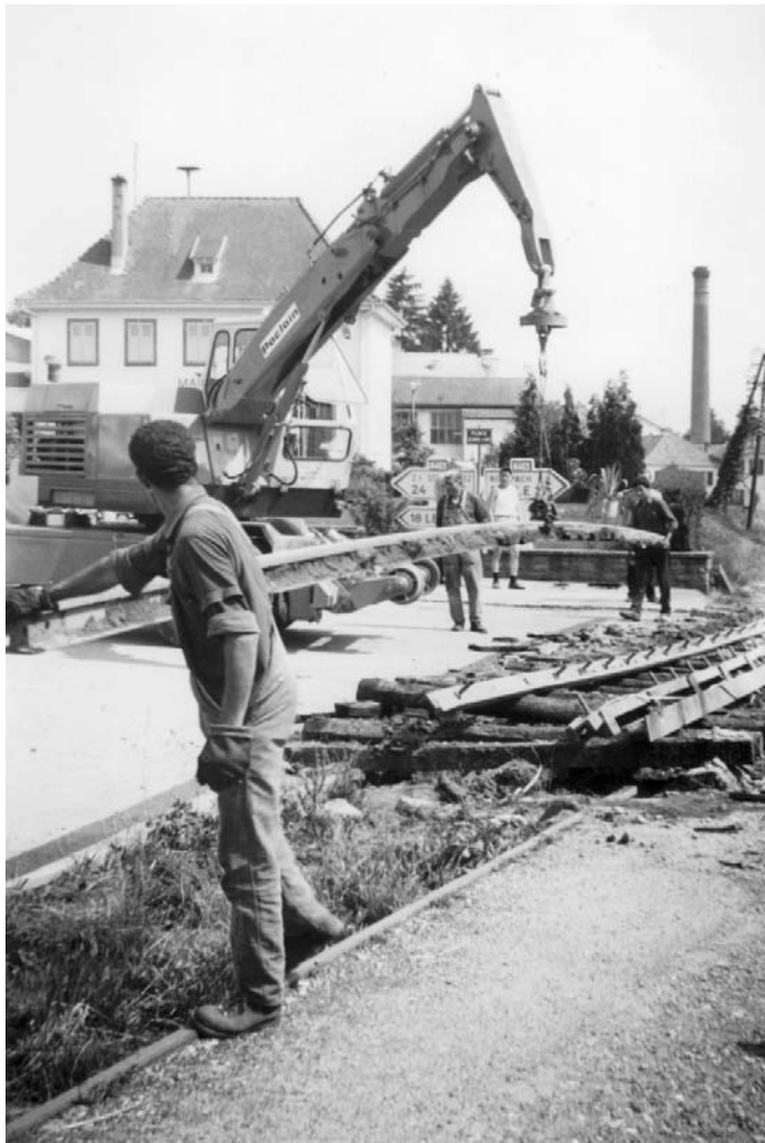
1969 : Enlèvement des rails.
