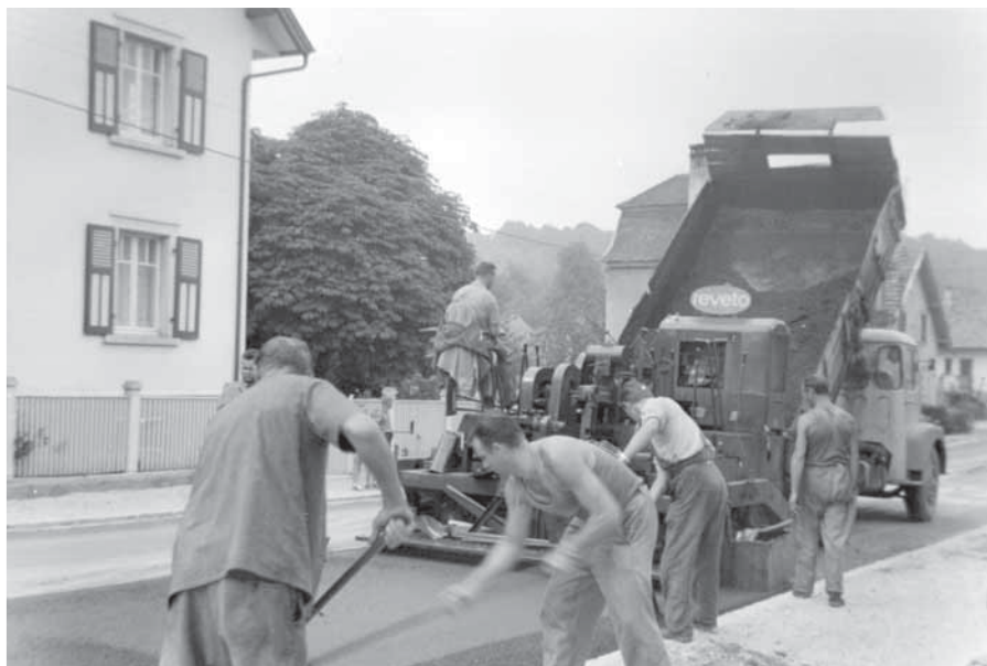
Pose du revêtement sur rue et trottoirs en 1963.
